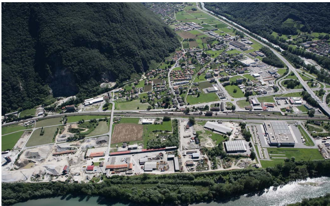
Zona industriale Castione
